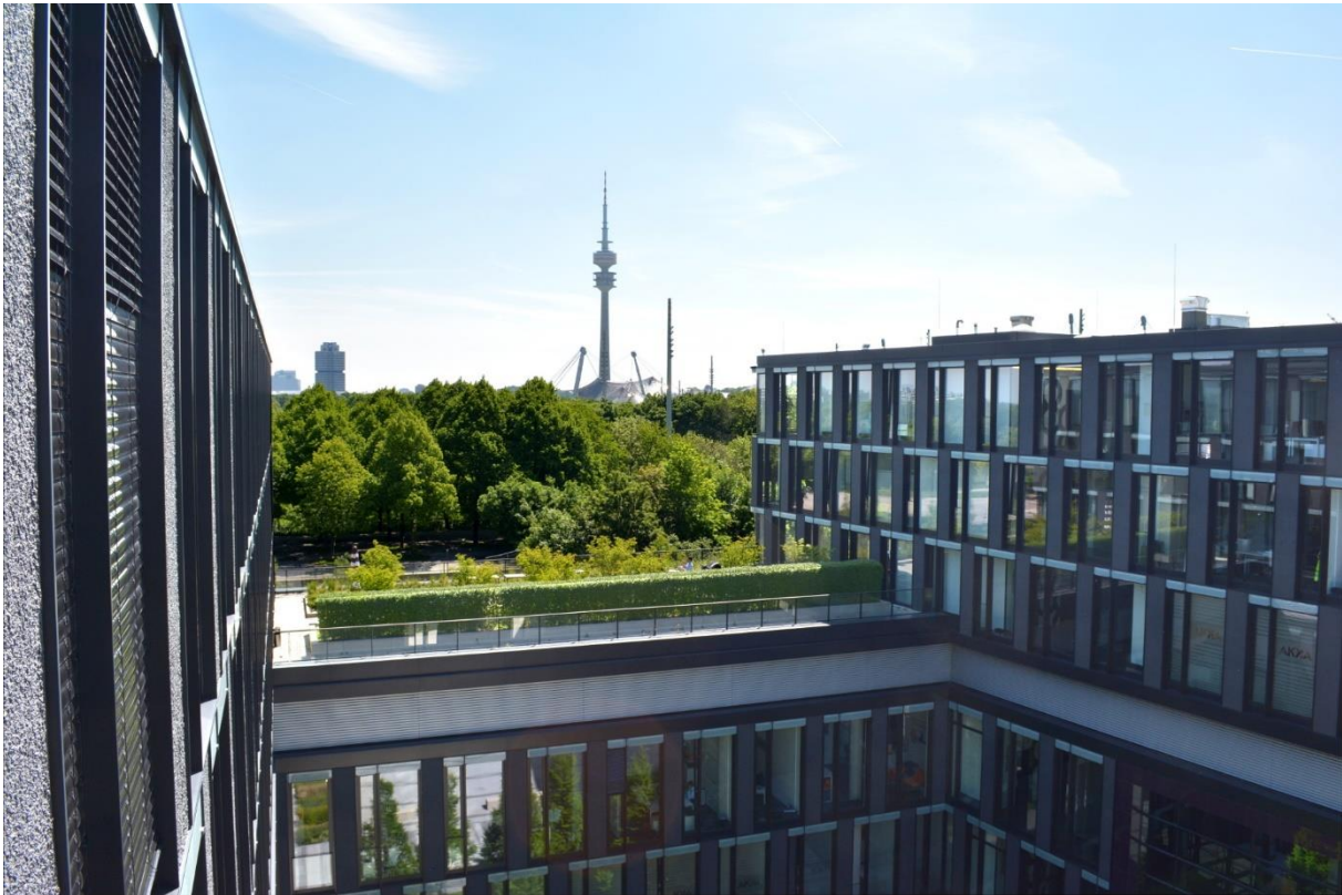
Bild 1: Neuer Unternehmenshauptsitz von Logivations im 88 North am Olympiapark
